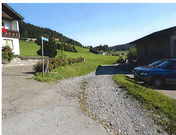
Abbildung 14: Zufahrt ab Feldlistrasse / Schitterstrasse
