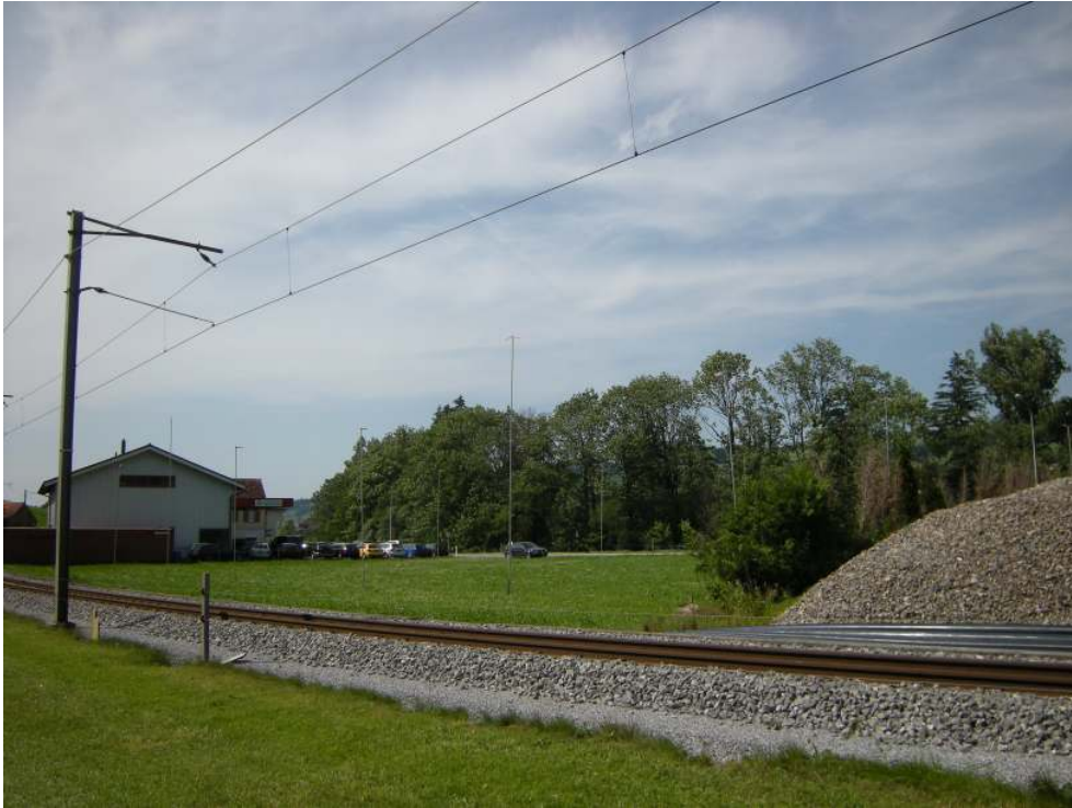
Möglicher Standort für Neubauten, Lage zukünftiger Bahnübergang
